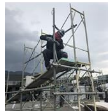
足場仮設工事
